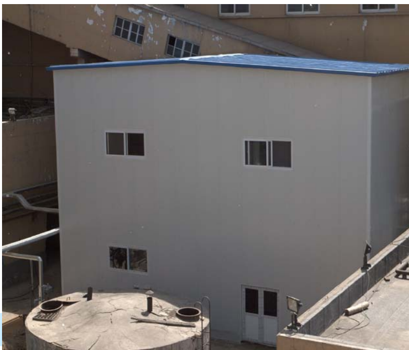
液态除尘及控制室
